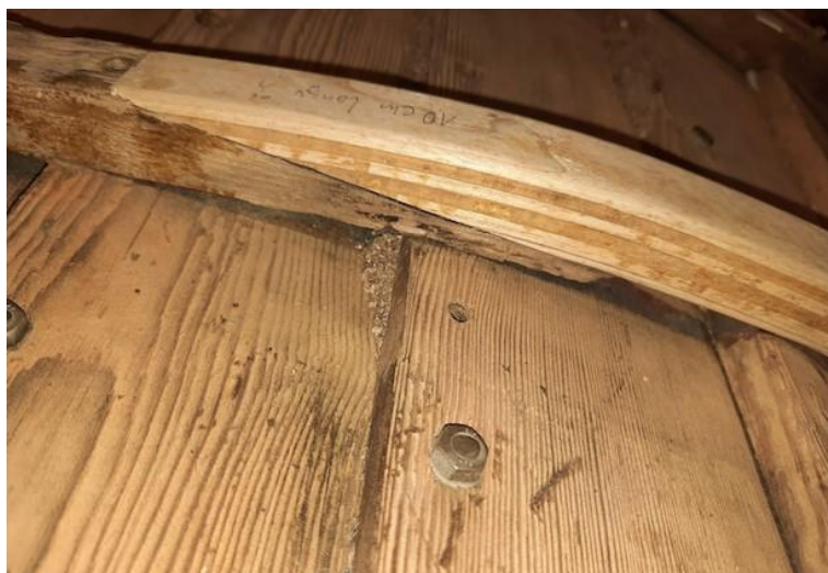
Das neue Spantsegment fertig zum Anschäften
