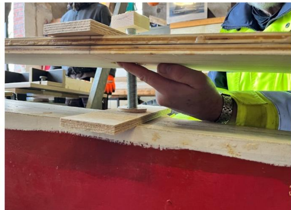
Exakte Ausrichtung der Bohrschablone
